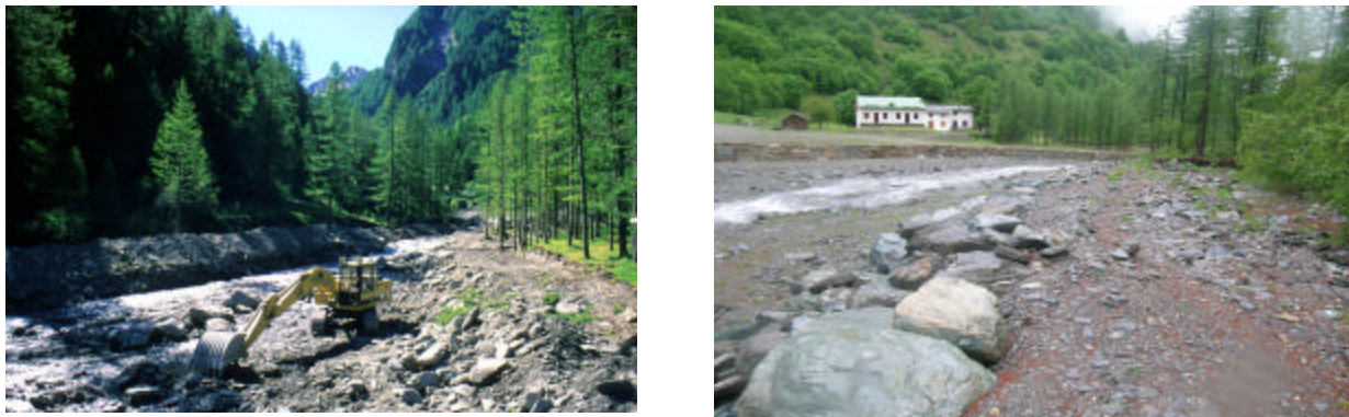
Figura 5. Opere in alveo dopo l'alluvione del 2000 e della situazione attuale a Ribba (Val Germanasca).
